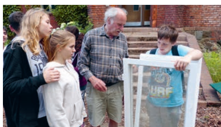
Michael Brück bei der Fenstersanierung
